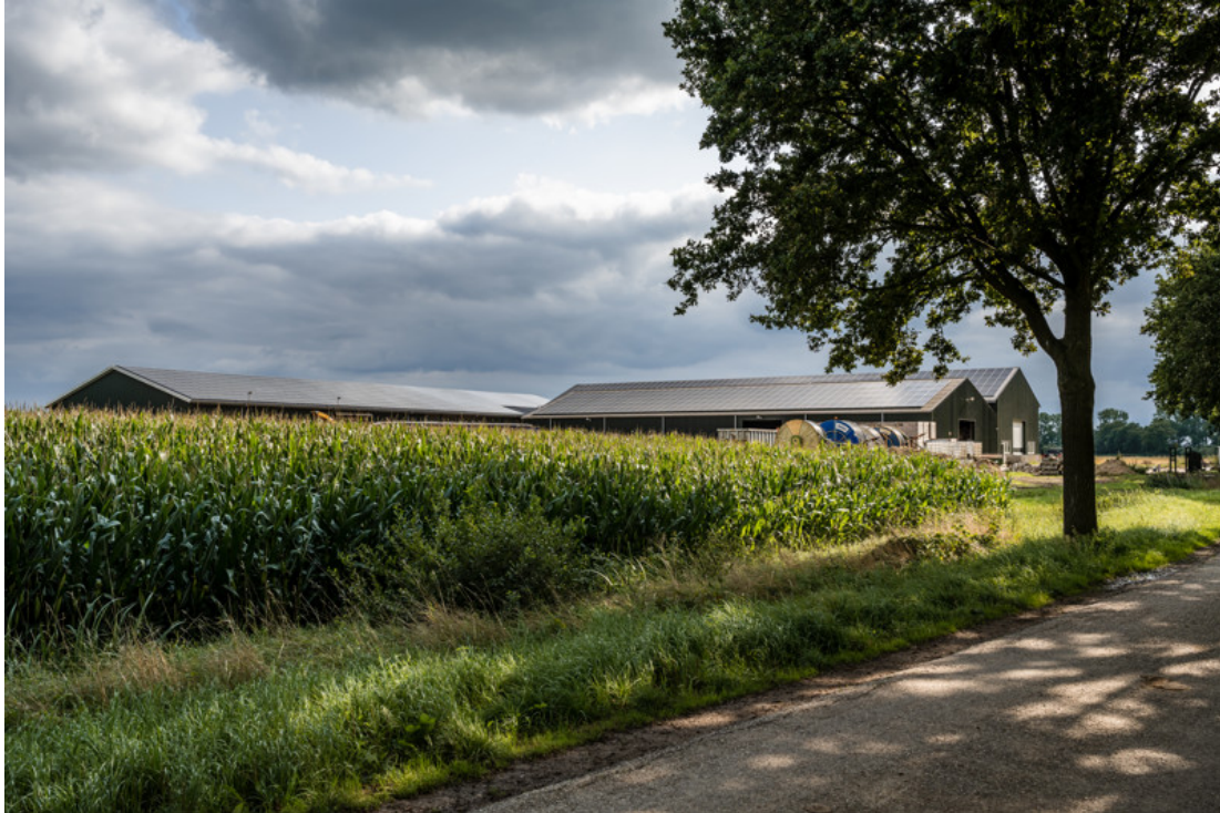
Foto: zonnepanelen op dak schuur boerderij, Henk Hulshof.
